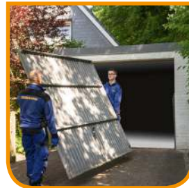
Ausbau und umweltgerechte Entsorgung
