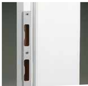
Schließblech (von vorne) nachträglich austauschbar
