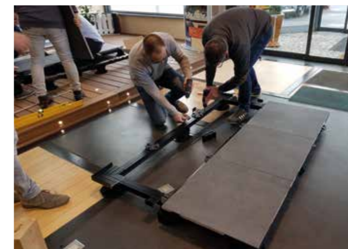
Schulung der Monteure auf das System vor der Ausführung.
