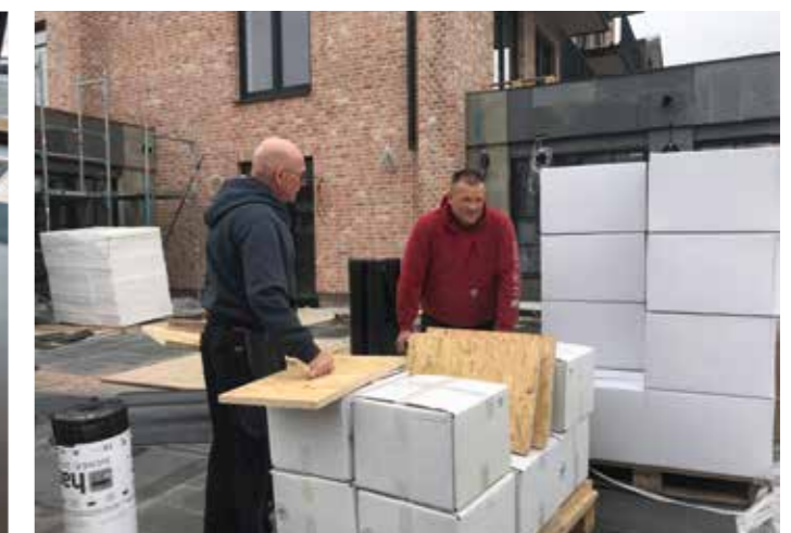
Einweisung auf der Baustelle und Betreuung während der Bauphase.
